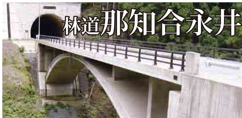
ひらのトンネルと入道屋敷橋
